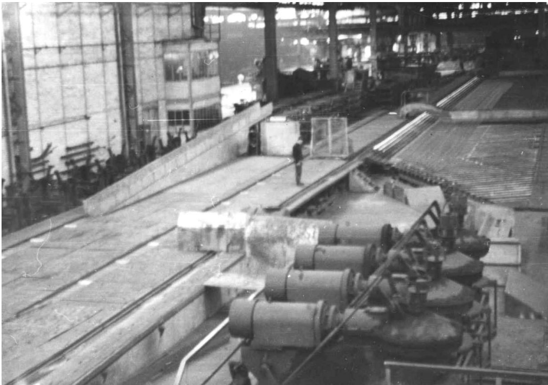
P.39 – Partie du hall.
