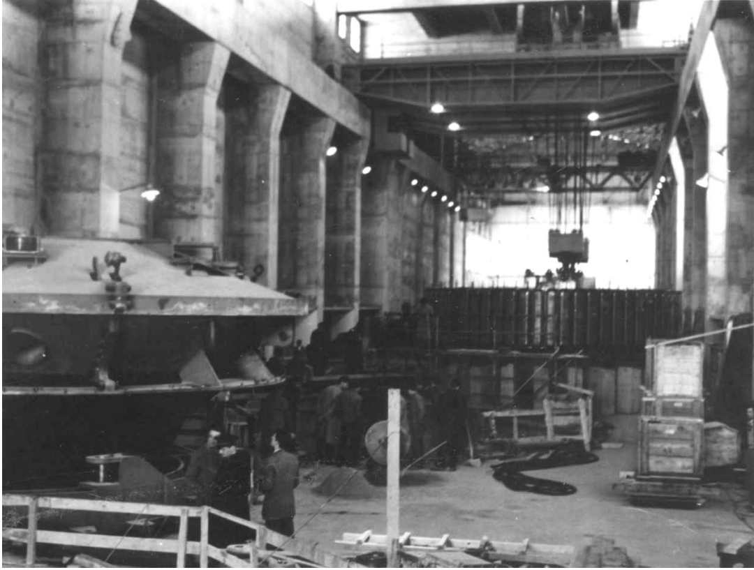
P.28 – Salle des machines.
