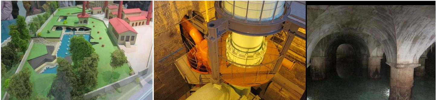
C'est une pompe à vapeur à balancier impressionnante qui a été conservée : 20 mètres de haut, dotée d'un condenseur avec 2 chaudières), faisant partie d'un ensemble de 3 pompes et 6 chaudières, avec 2 bassins voûtés filtrants de 1600 et 2200 m<sup>2</sup>, implantés dans la nappe phréatique du Rhône.
